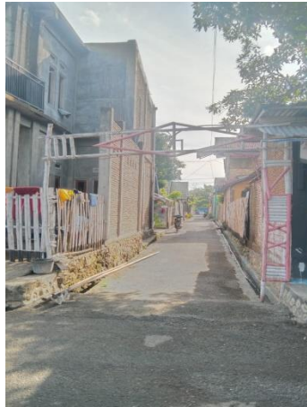
Gambar 2. Pembangunan Decker hanya di satu RT
